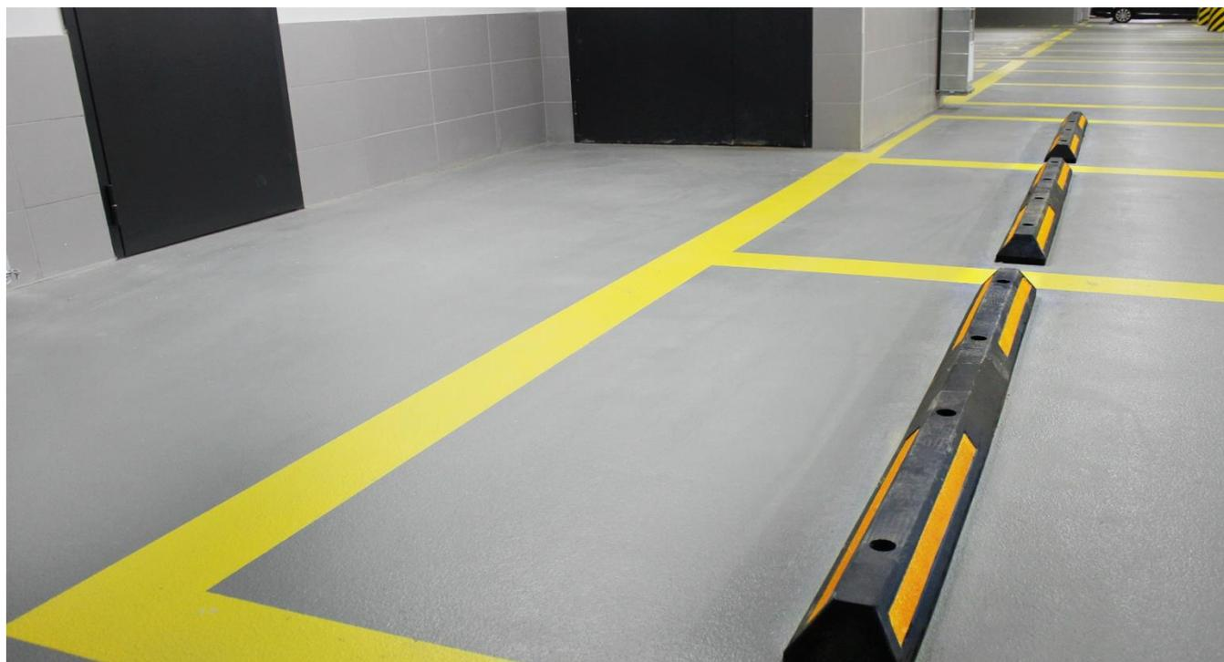
Колесотбойники успешно используются в качестве барьерного ограждения парковочного места, помогая водителю правильно и быстро припарковать свой автомобиль и зафиксировать его положение, предотвращая столкновение с другими транспортными средствами.
